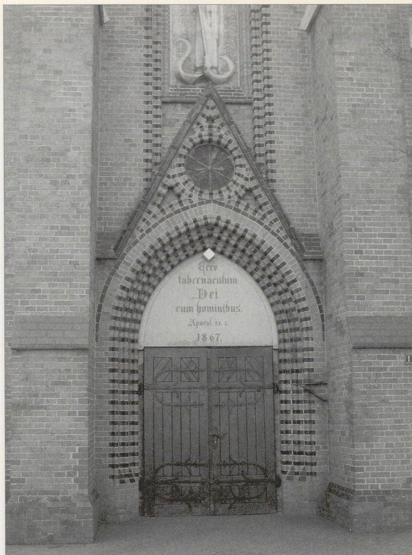
ABB. 11A _ Aktuelle Ansicht des Nordportals; Zustand Mai 2009.
