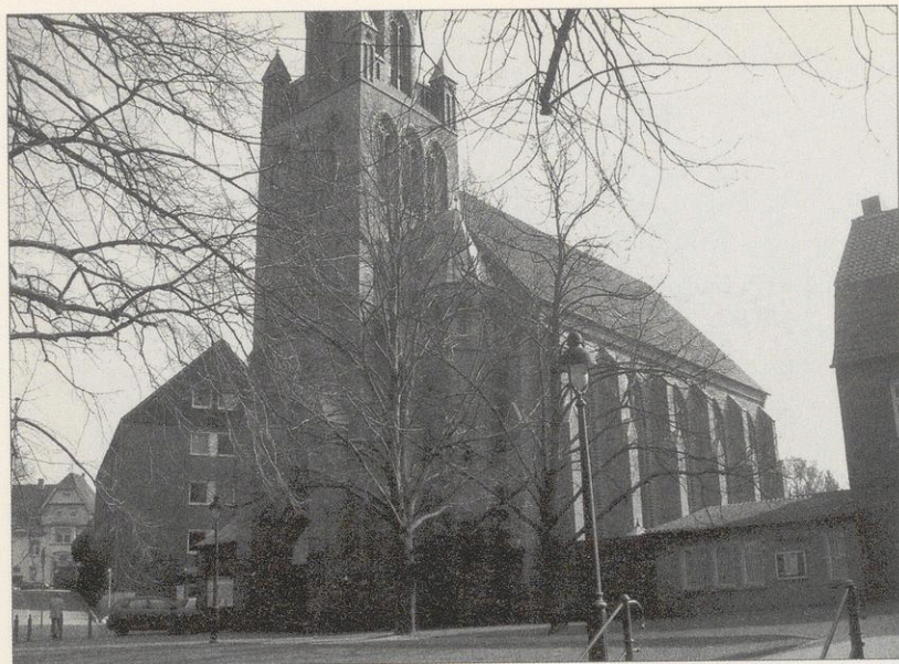
ABB. 1 _ Ansicht der Kirche von Nordwesten; Zustand Mai 2009.
