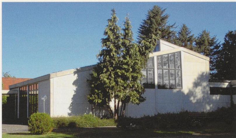
ABB. 11 _ Großenwieden, St. Hedwig, Ansicht von Osten, 2015
