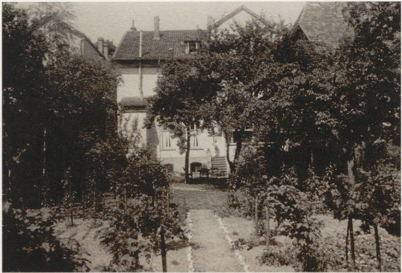
ABB. 2 _ Gartenansicht des Wohnhauses Löbenstein, Goslarsche Straße 64
