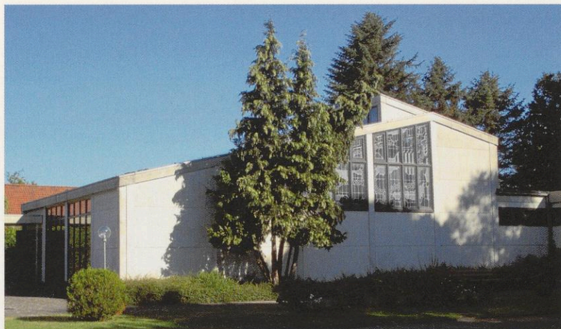
ABB. 11 _ Großenwieden, St. Hedwig, Ansicht von Osten, 2015
