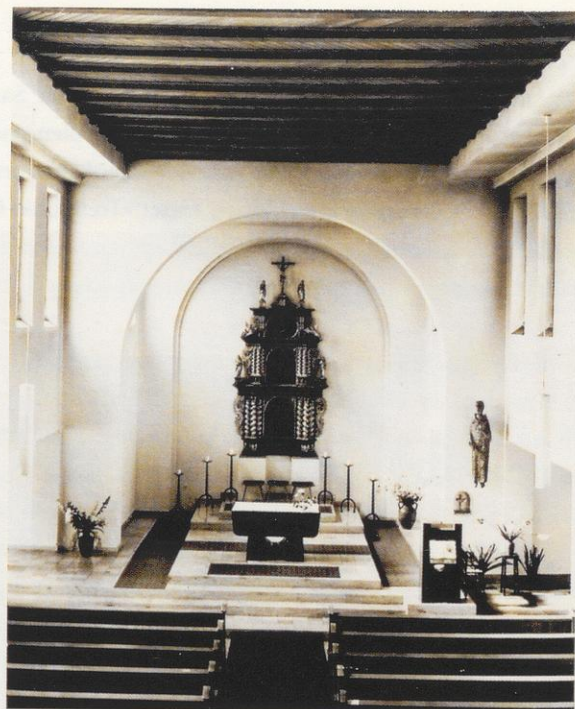
St. Bruder Konrad, Hannover, 1936, Profanierung 2013, Abriss
