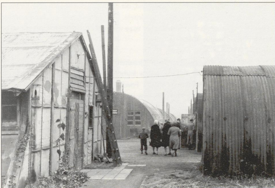
Holzbaracke und Nissenhütten im Lager Friedland, 1950er-Jahre
