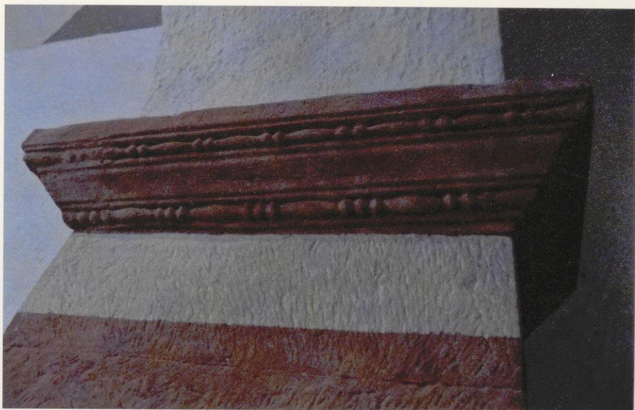
Zwei griechisch-byzantinische Perlenschnüre um die Kämpferkapitelle – hier am Beispiel des Pilasterkapitells – in der mittleren Empore des nordwestlichen Querschiffes
