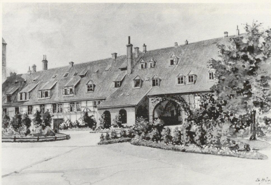
Hildesheim, St. Bernward-Krankenhaus, um 1900
