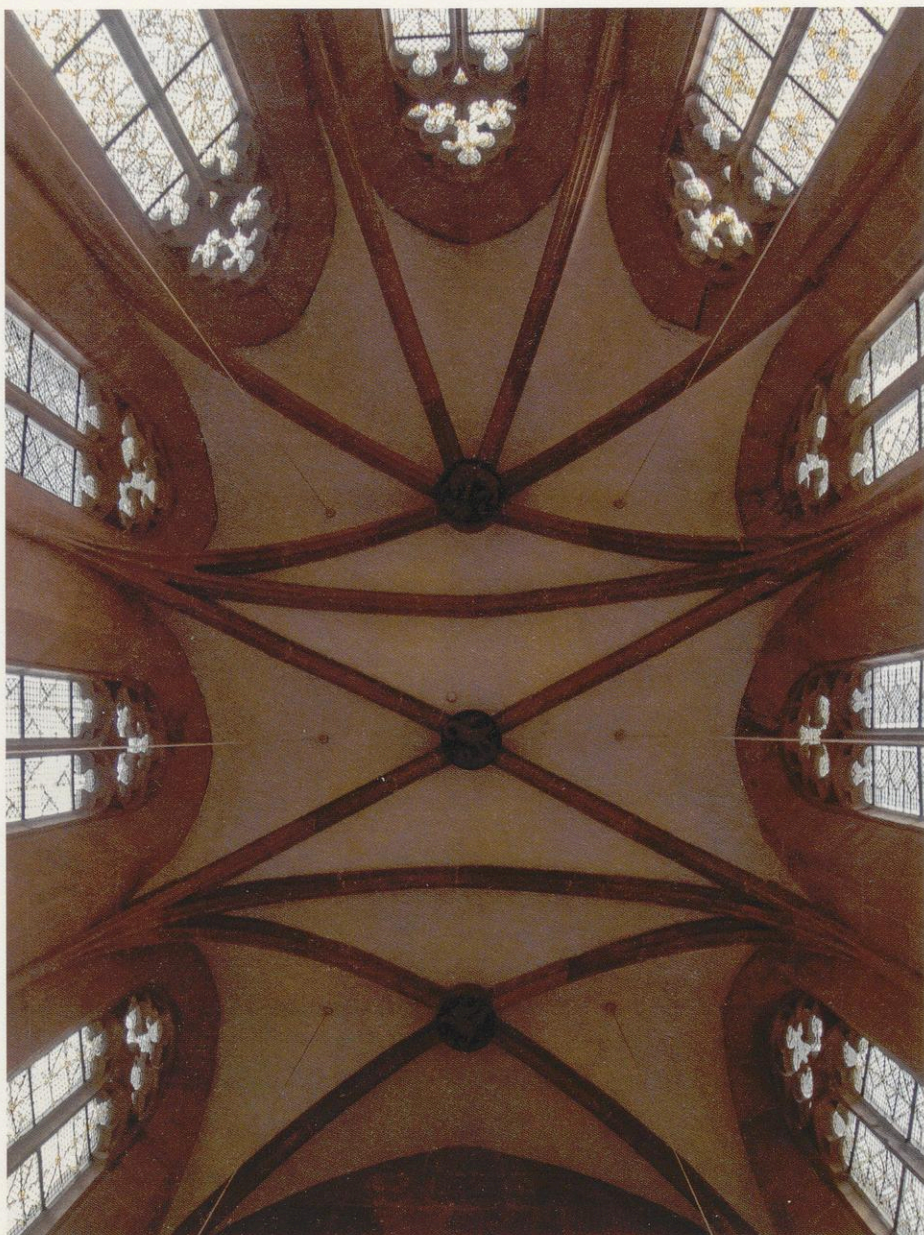
Kreuzrippengewölbe mit Schlusssteinen in der St. Anna-Kapelle
