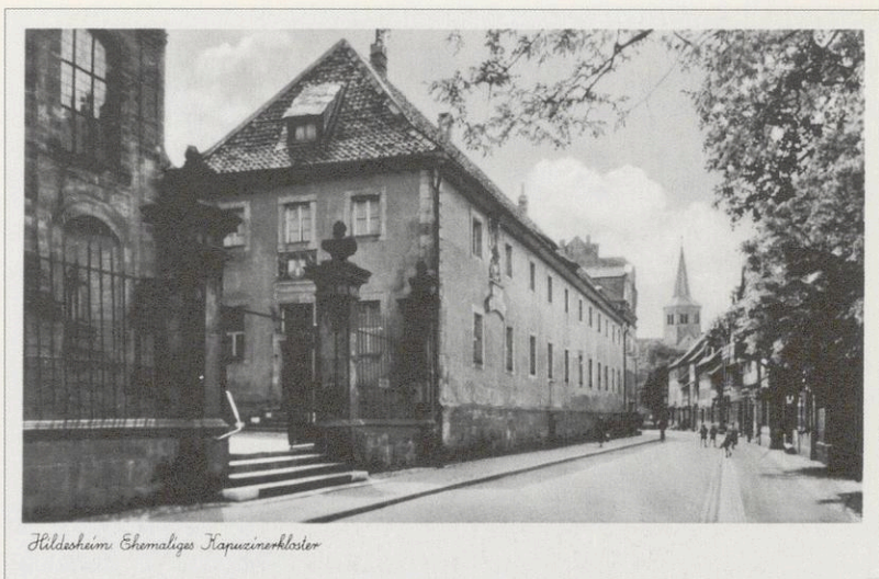
ABB. 4 – Priesterseminar, Außenansicht Brühl
