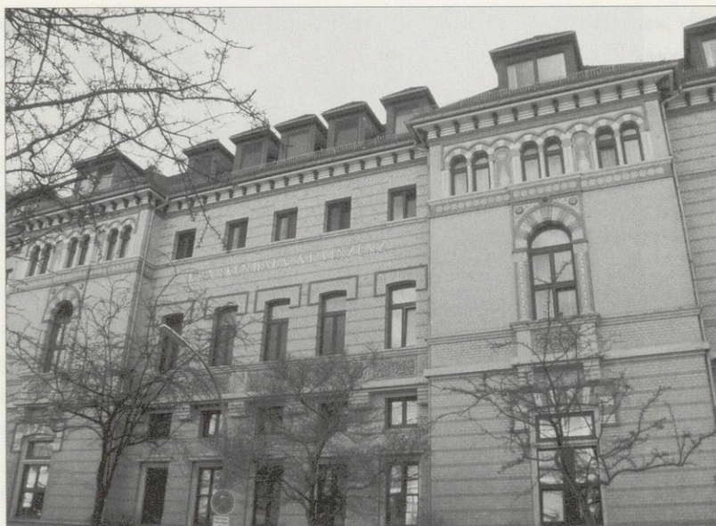
ABB. 20 _ Braunschweig, Krankenhaus St. Vinzenz, Ansicht von der Bismarckstraße
