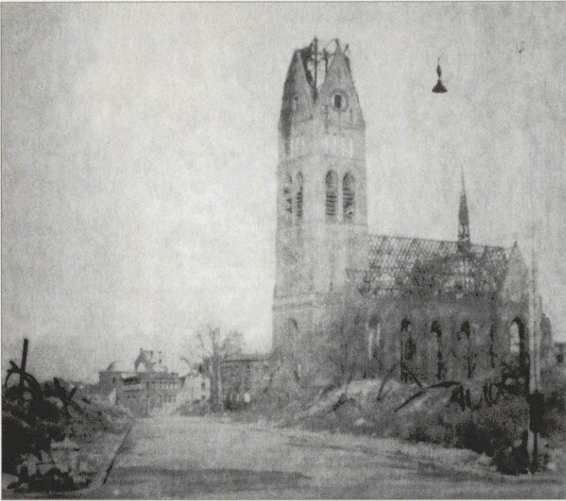
ABB. 4 _ Zerstörungszustand der Kirche, Ansicht von Süden, undatiertes Foto (ca. 1945)
