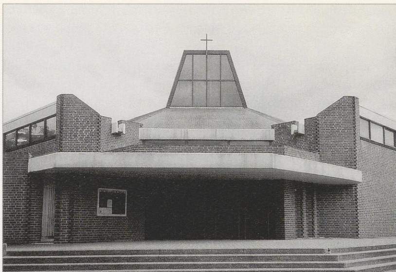
ABB. 8 Braunschweig-Heidelberg, St. Bernward, Hafkemeyer (Braunschweig) 1972.
