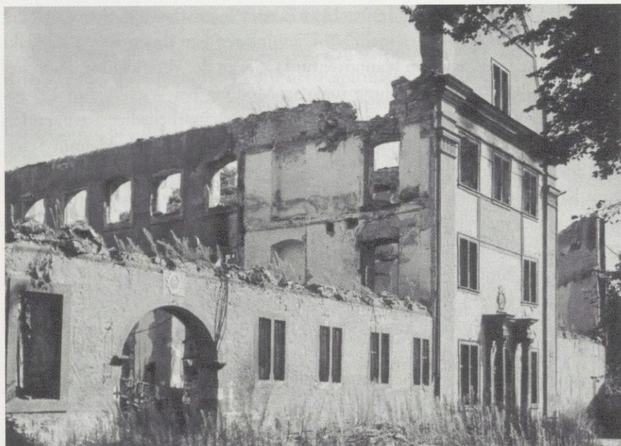
Das zerstörte Schulgebäude
