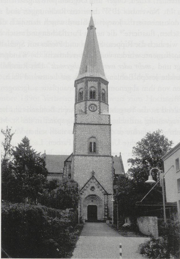
Abb. 8: Ansicht der Turmfassade vom Hohen Weg aus
