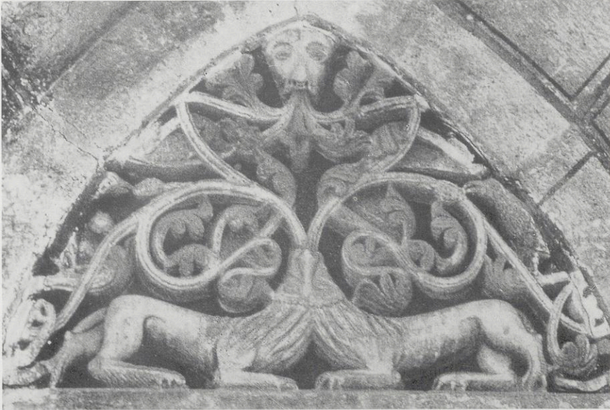
Abb. 7: Mühlhausen, Tympanonrelief vom Südportal der Marienkirche
