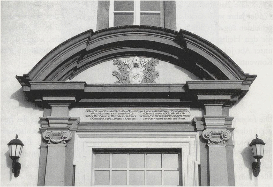
Abb. 2: Nordportal des Westflügels, (Detail) 1717
