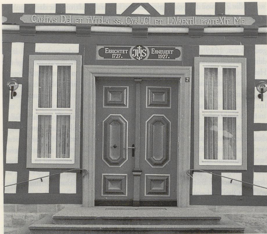
Eingang zum Propsteigebäude mit Chronogramm
