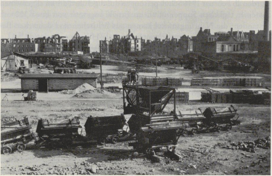
Räumen und Wiederverwerten von Trümmern in der Südstadt (April 1949)
