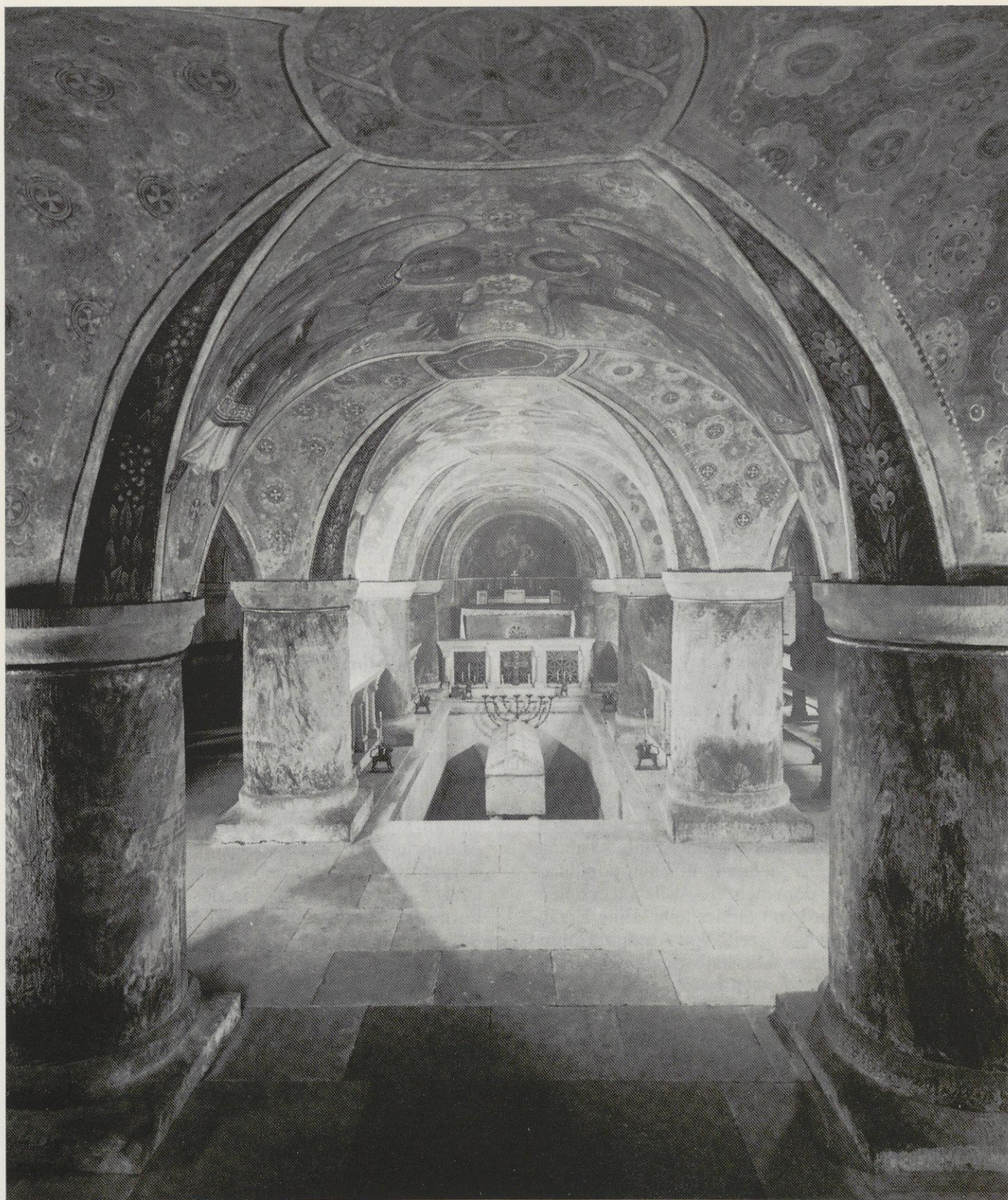
Bernwardsgruft nach der Restauration von 1893
