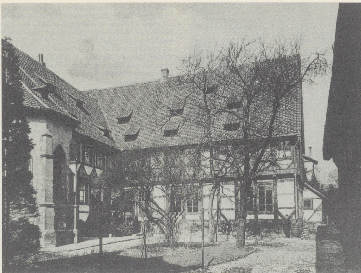
Kurie im Hof der Domdechanei — 1591 erbaut, im Untergeschoß Sitz des Konsistoriums Hildesheim
