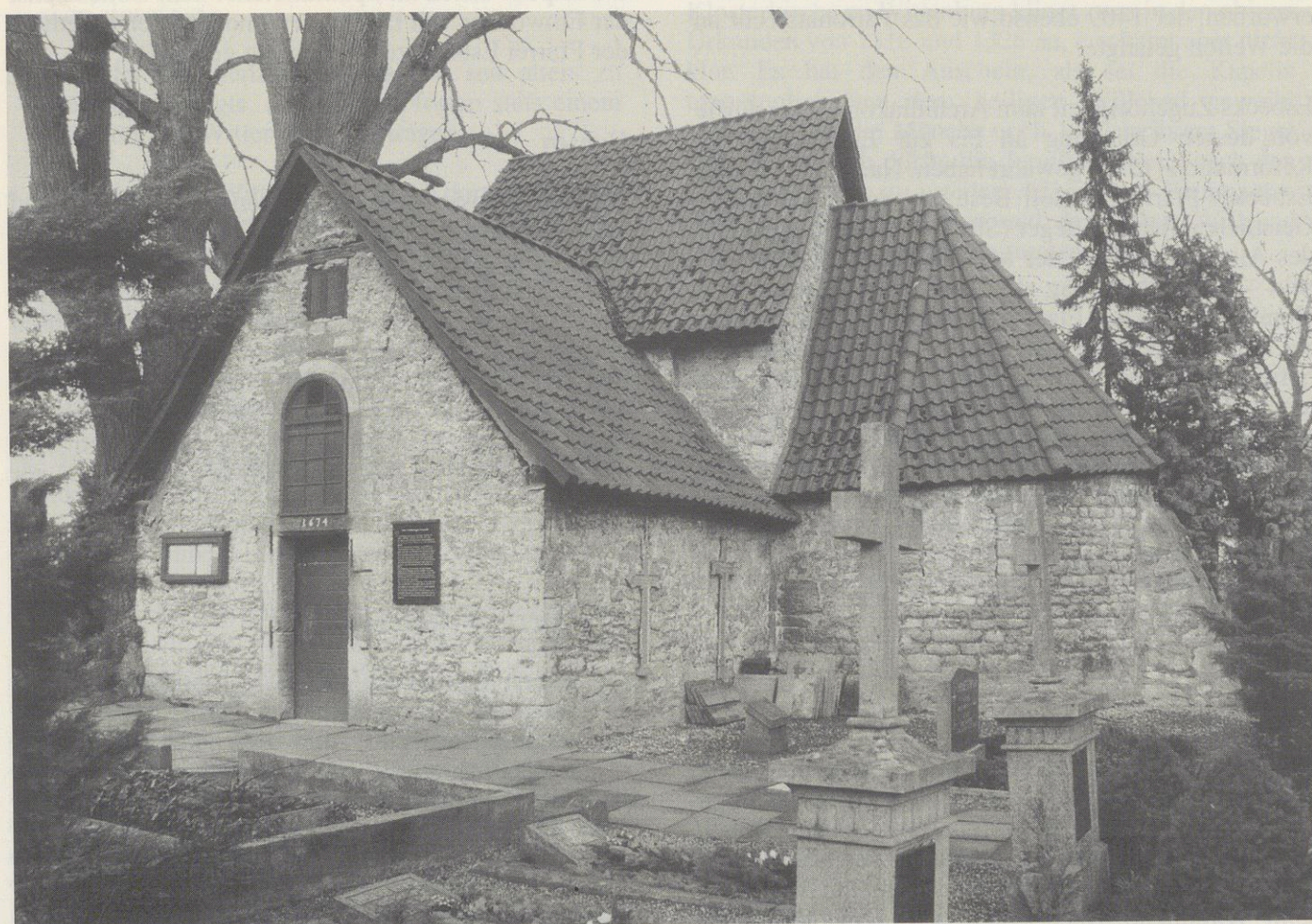
Romanischer Chor und Apsis der ehem. Pfarrkirche zu Feldbergen bei Banteln mit barockem Anbau von 1674
