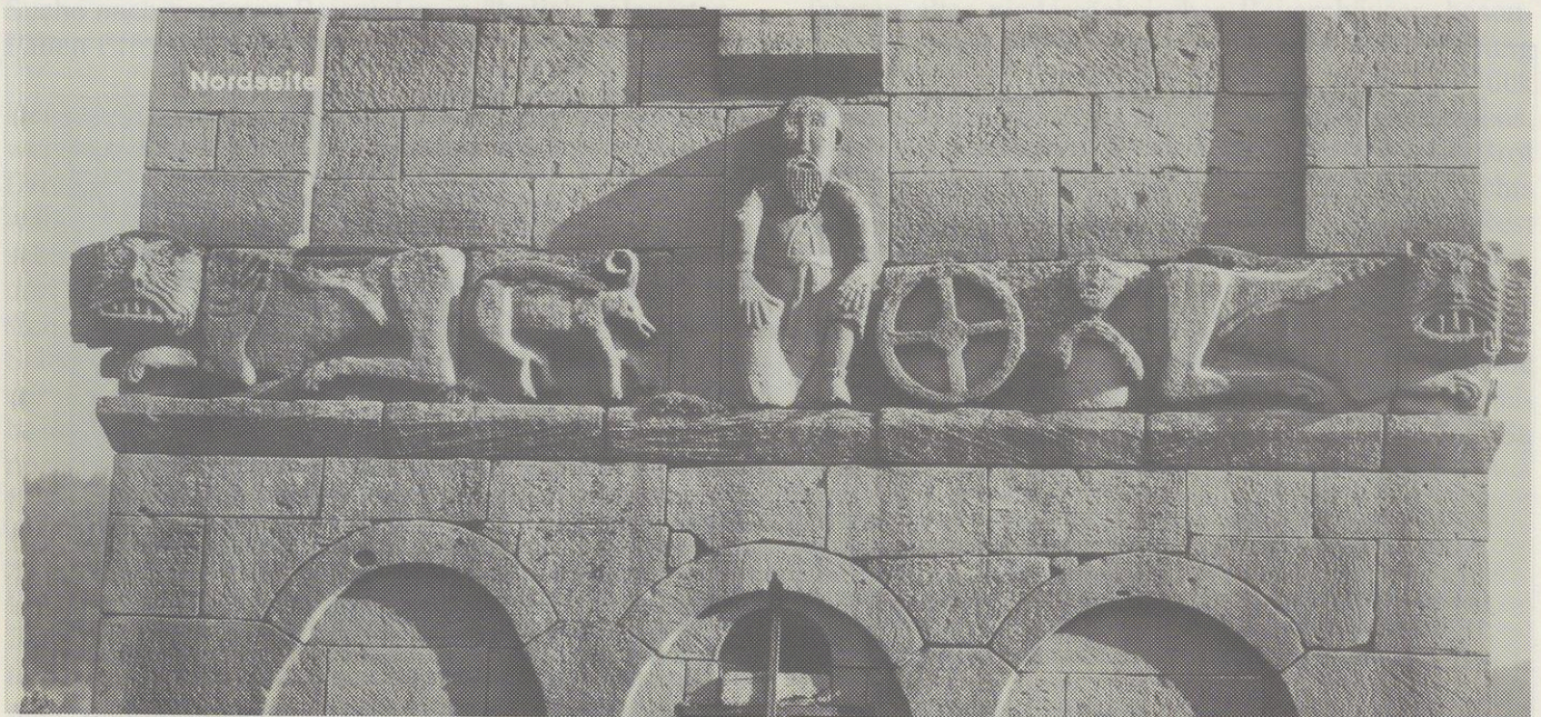
Abb. 19: Figurenfries am Peter-Pauls-Turm in Hirsau, Nordseite
