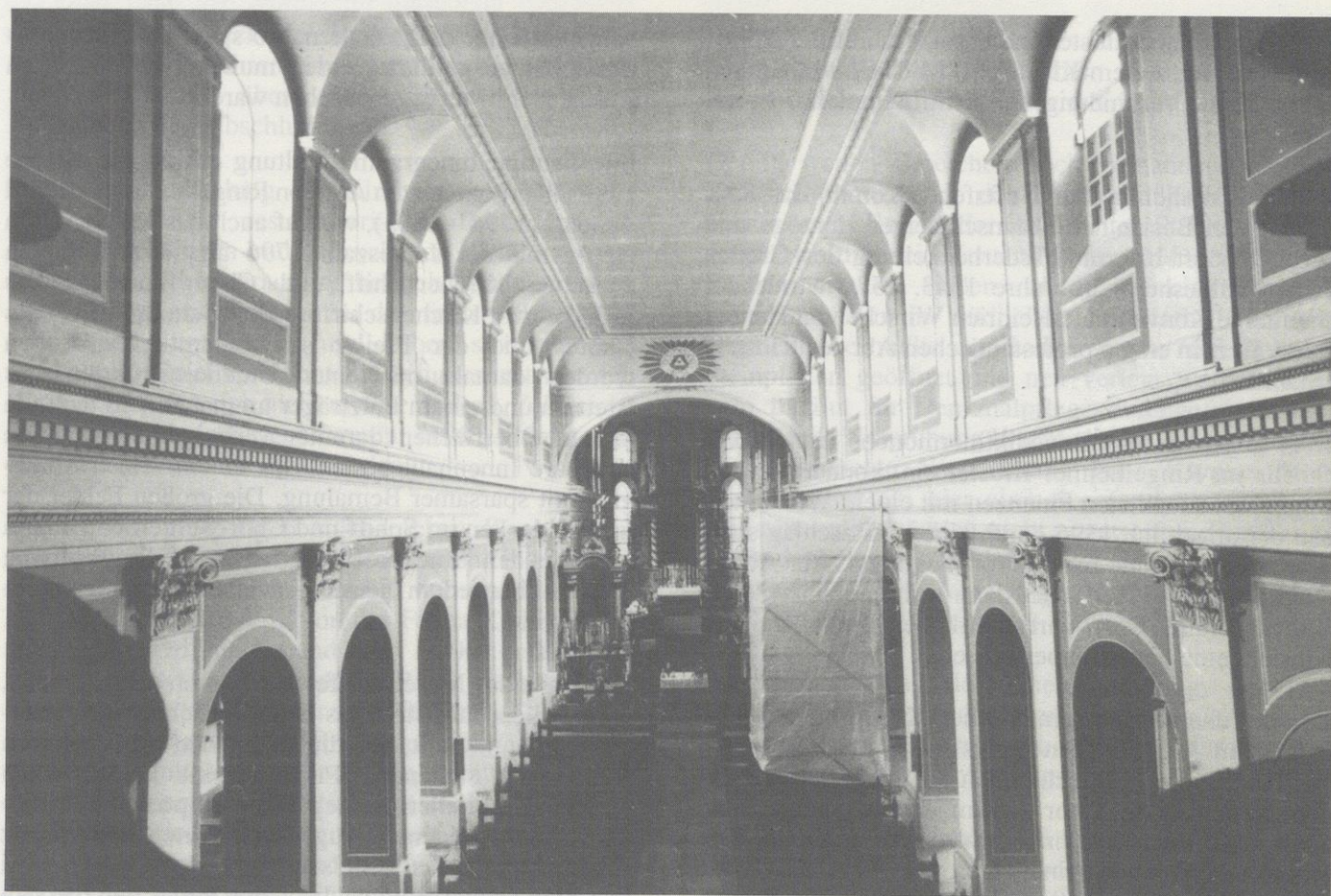
Ringelheim, St. Abdon und Sennen, Mittelschiffstukatierung vor der Renovierung
