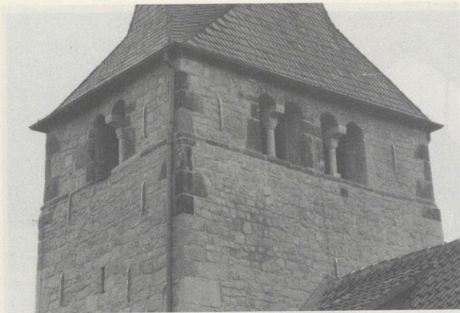
Abb. 3: Das Glockengeschloß der Bülthamer St.-Martins-Kirche mit den erneuerten Teilungssäulen nebst Kapitellen in den alten Klangarkaden
