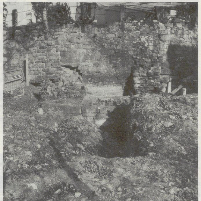
Abb. 8: Domhof 15/16, Fundament und Wandnische des Turmes, 18. Jhdt.
