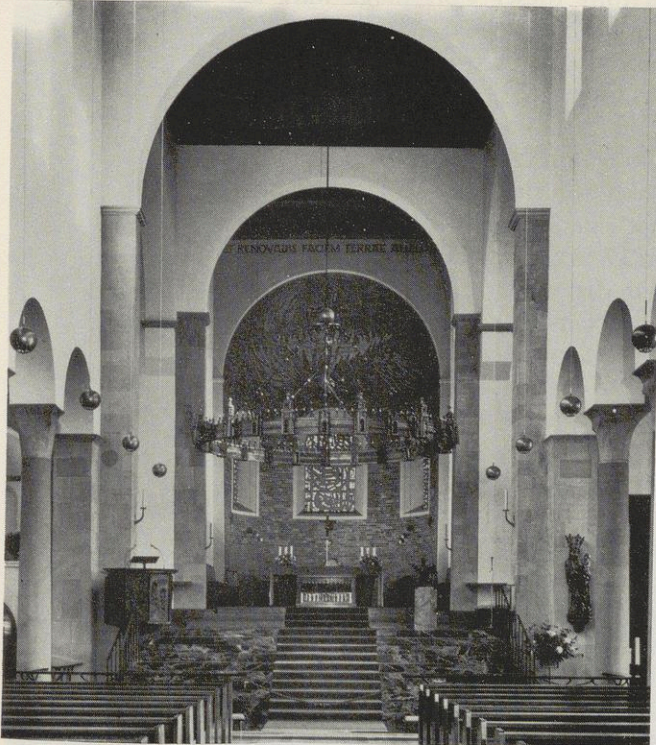
Der wiederaufgebaute Hildesheimer Dom. Blick nach Osten in den Chor.
