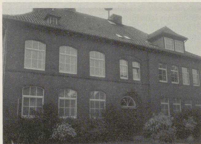
Die Schule nach dem Umbau. Blick vom „Hohen Weg“ auf die Ostseite des Gebäudes. (PrA Köhler, Aufnahme von 1984)
