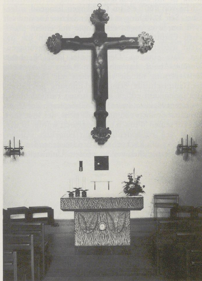
Ottbergen, Innenansicht der Kapelle nach der Renovierung.
