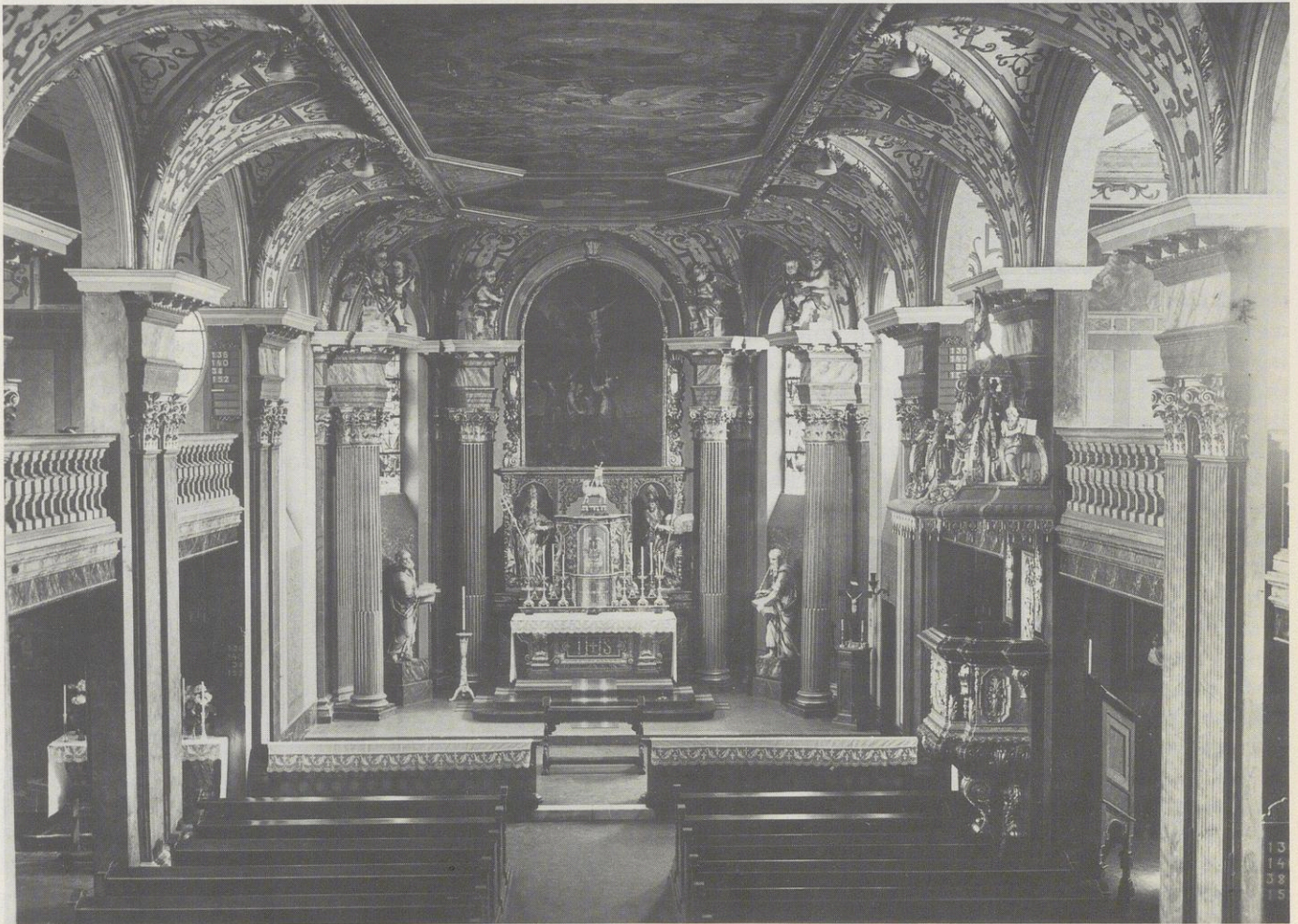
Innenansicht der im Zweiten Weltkrieg zerstörten St.-Nikolai-Kirche.
