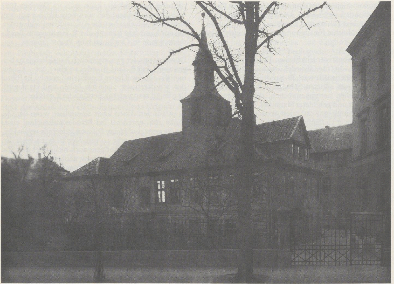
Ostansicht von St. Nikolai, eineinhalb Jahrhunderte lang die einzige katholische Kirche in Braunschweig. Aufnahme von 1907. Die Bauvorschrift wies an, daß katholische Gotteshäuser in der Straßenflucht zu stehen und hinter einer Häuserwand zurückzutreten haben.
