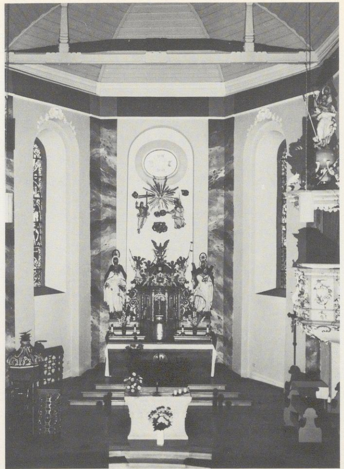
Innenaufnahme von St. Mauritius in Duderstadt-Desingerode nach der Renovierung Foto: W. Heinrichs, 8. 8. 1981
