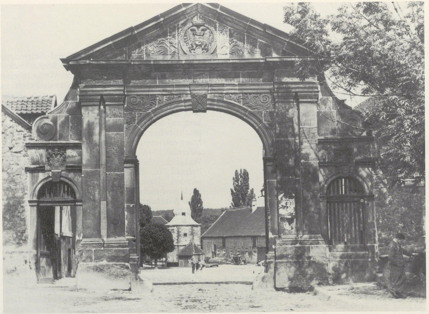
Bild: Das 1716 errichtete »Türkentor«, das demnächst wiedererrichtet werden soll. Foto: Historische Aufnahme im Pfarrarchiv St. Ludger.
