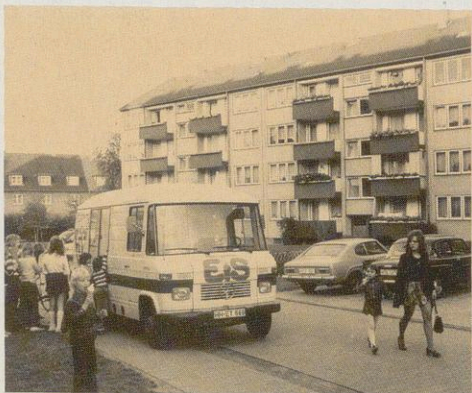
Mitte: Im Stadtteil Hannover-Kleefeld errichtete das Heimatwerk Hannover diese Wohnungen.
