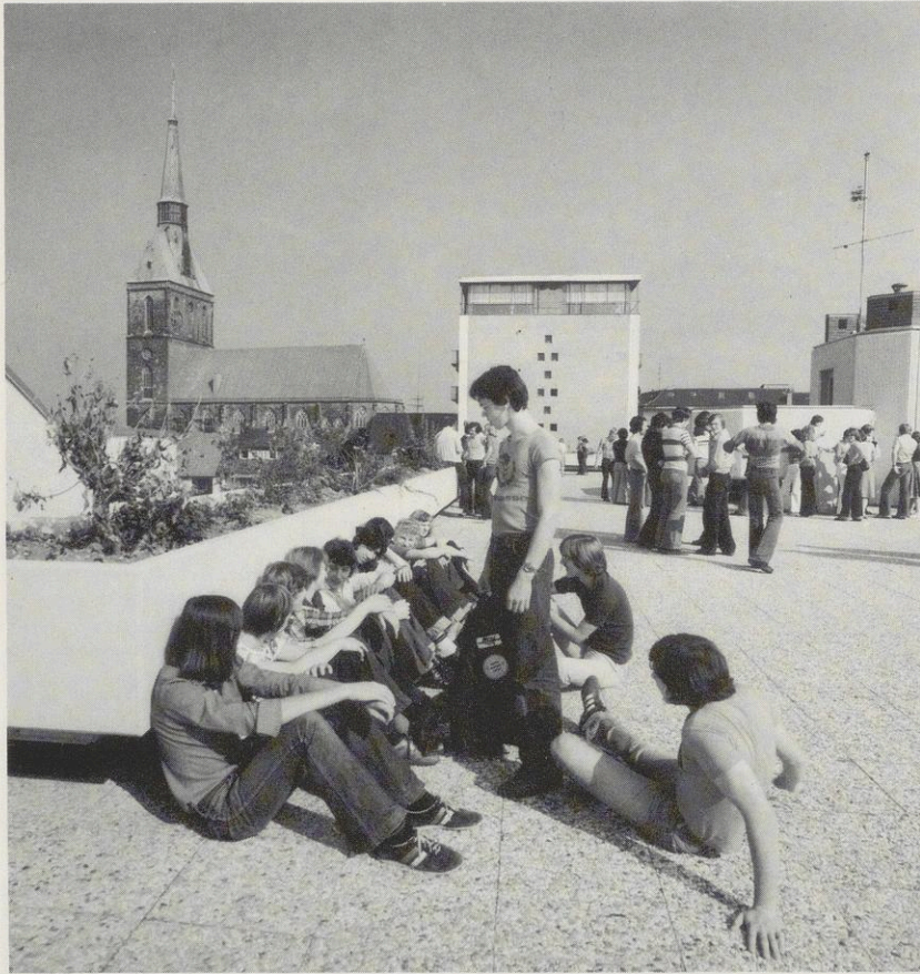
Oben links: Kein Dachgarten, aber ein Dach-Schulhof, wie ihn jetzt das neue Schulgebäude der Kollegstufe besitzt. Hier ist es auf jeden Fall luftig. Außerdem kann man wirklich fern-sehen. Links im Bild die Sankt-Andreas-Kirche. Der Fotograf mußte natürlich auf den Turm der Kreuz-Kirche klettern.
