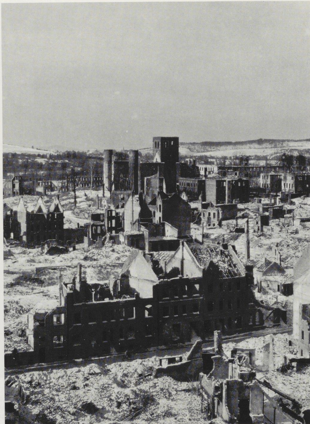
Mit den Wohn- und Geschäftshäusern auf Straßen und Plätzen gingen auch die Gotteshäuser im Bombenhagel des zweiten Weltkrieges zugrunde. Tausende verloren ihr Leben. Deutschland sank buchstäblich in Schutt und Asche.
