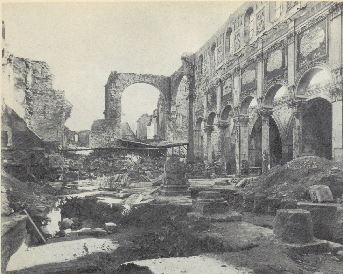
9 Inneres des Domes nach der Zerstörung 1945 – Blick nach Osten
