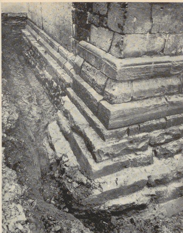
Abb. 5 b Links oben dieselbe Situation wie auf Abb. 5 a; im Vordergrund rechts der frühgotische Sockel der Nördwestecke des Turms und sein abgetreptes Fundament
