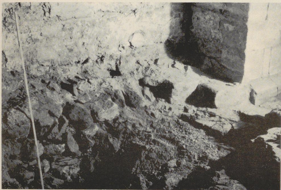
Abb. 12 Trockengrundmauer der ersten Steinkirche, darüber (unter Putz) das Quadermauerwerk der romanischen Turm-Nordwand und (darauf von rechts aufsetzend) die mit einem einfachen Sockel versehene Nordwange des frühgotischen Gewölbebogens
