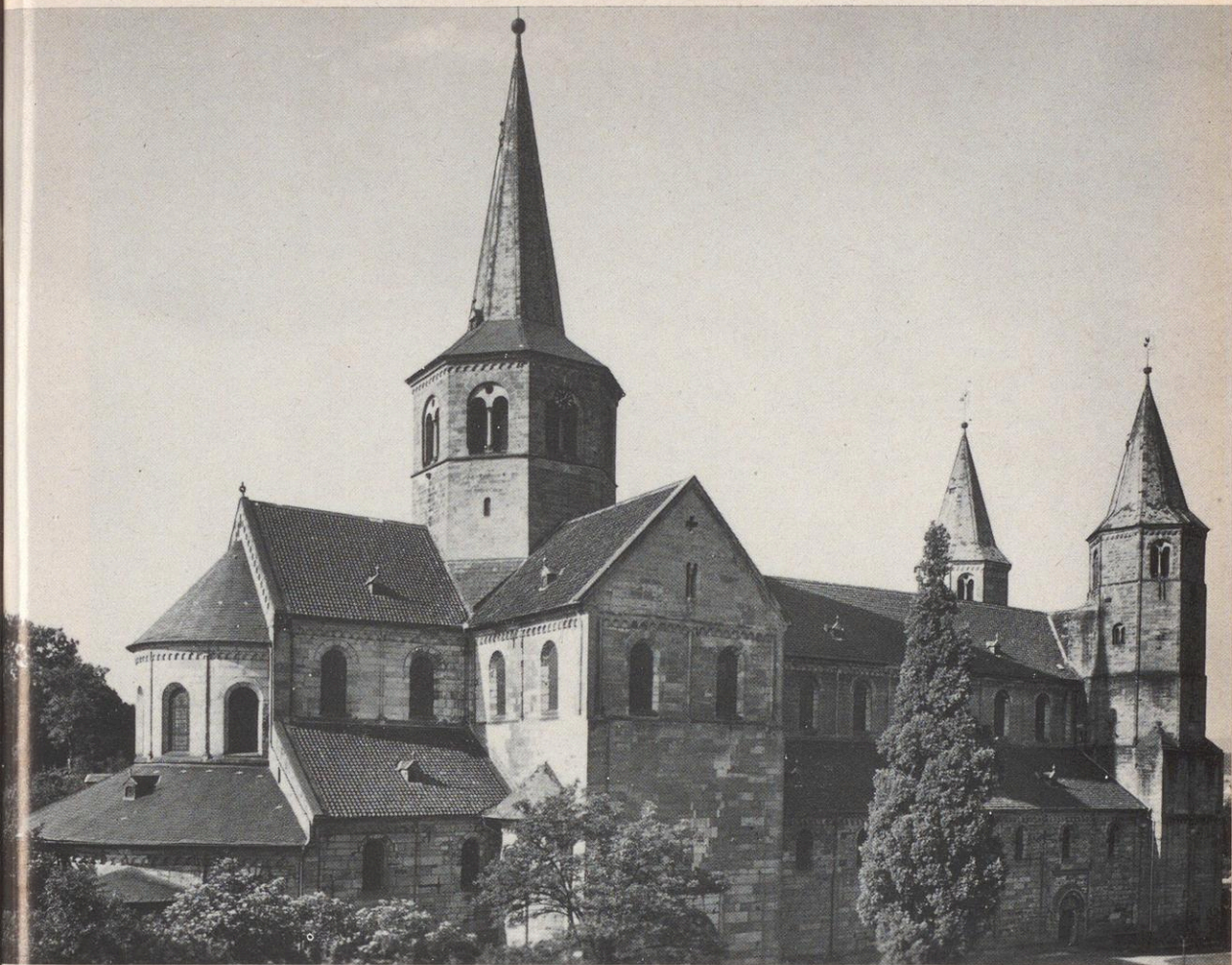
VIII St.-Godehardi-Kirche, Gesamtansicht von Nordosten
