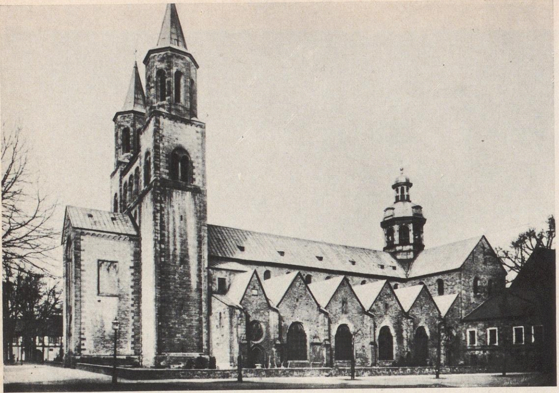
Vor der Kriegszerstörung: Ansicht von Südwesten
