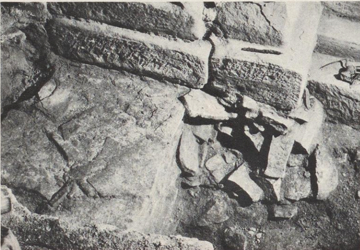
Abb. 13. Ansatz derselben Spannmauer am inneren romanischen bzw. frühgotischen Turmsockel (6).
