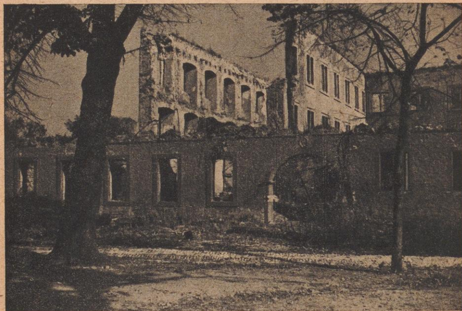
Josephinum am Domhof vor und nach der Zerstörung
